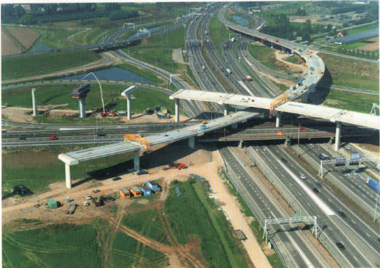
Gebogen SKK-liggers met een boogstraal van 400 m, project VARI Ridderkerk
