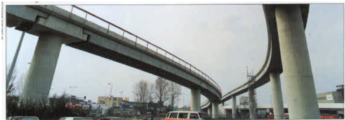
Boogviaduct metro ringlijn Amsterdam, bekroond met de Betonprijs 1995 en de BiBM-Award 1996
